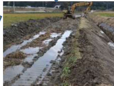
▲重機で法面を補修していきます。
