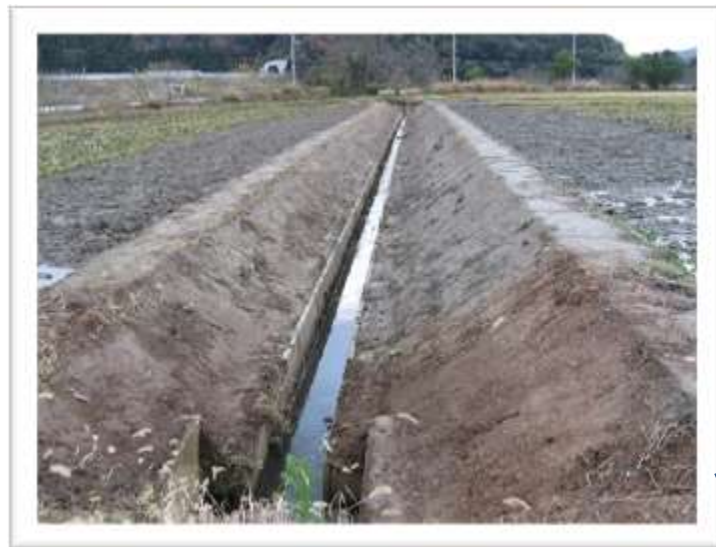
▲補修が完了した排水路
