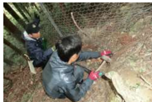
▲下からの侵入を防ぐために穴を鉄杭などでふさぎました。
