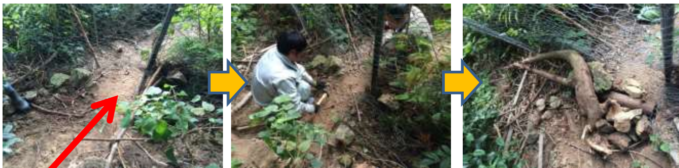
▲入れないように杭を打ち直しました
