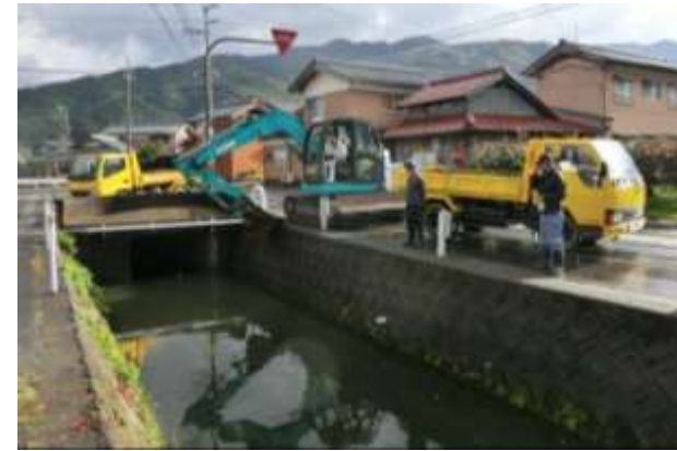
▲重機を使って泥をすくい取ります。
