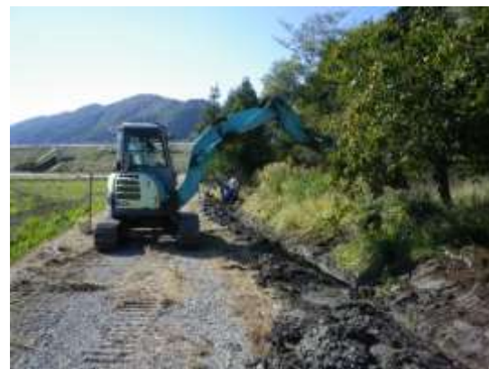
▲加屋地区の水路修繕
