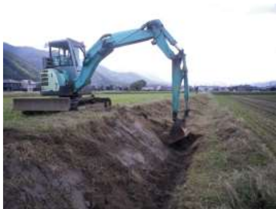
▲清水川南地区の畦畔修繕
