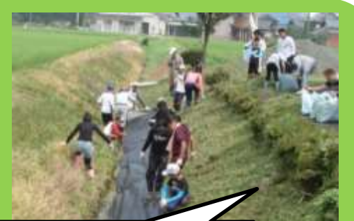
子ども育成会による防草シートの設置作業
