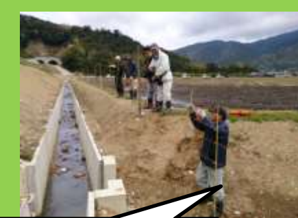
農家組合員による電気柵設置作業
